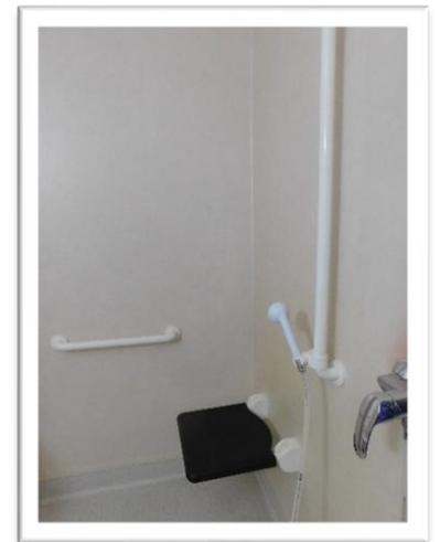
Elles sont composées d'un siège de douche, d'une sonnette, d'un lavabo permettant l'accès en fauteuil roulant, d'un WC avec barre d'appui, un souffleur d'air chaud pour le chauffage.
